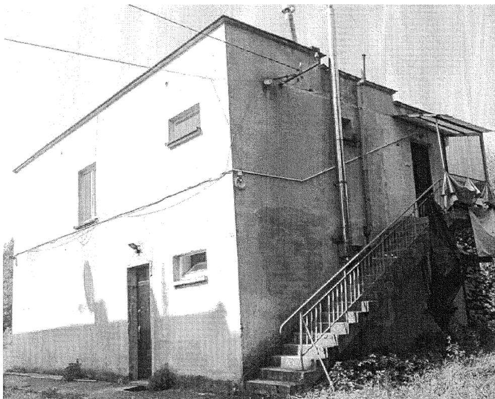
Rys. 16 Mały dom katechetyczny w Wojniczu, elewacja wschodnia i północna
